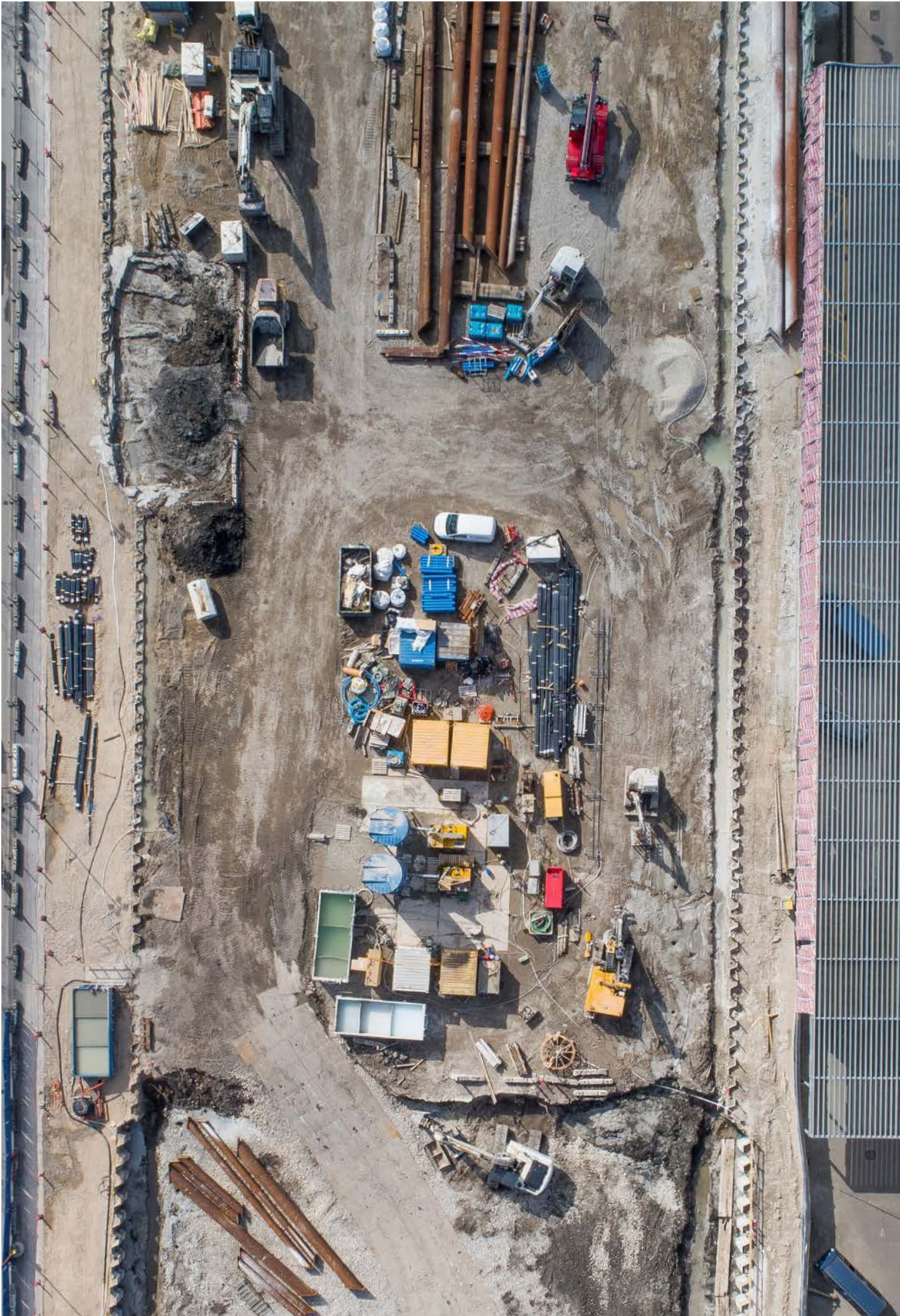
Scandic Copenhagen Spectrum. En av Danmarks største byggeplasser. Bygget skal huse Scandic sitt største hotell med 632 rom.
