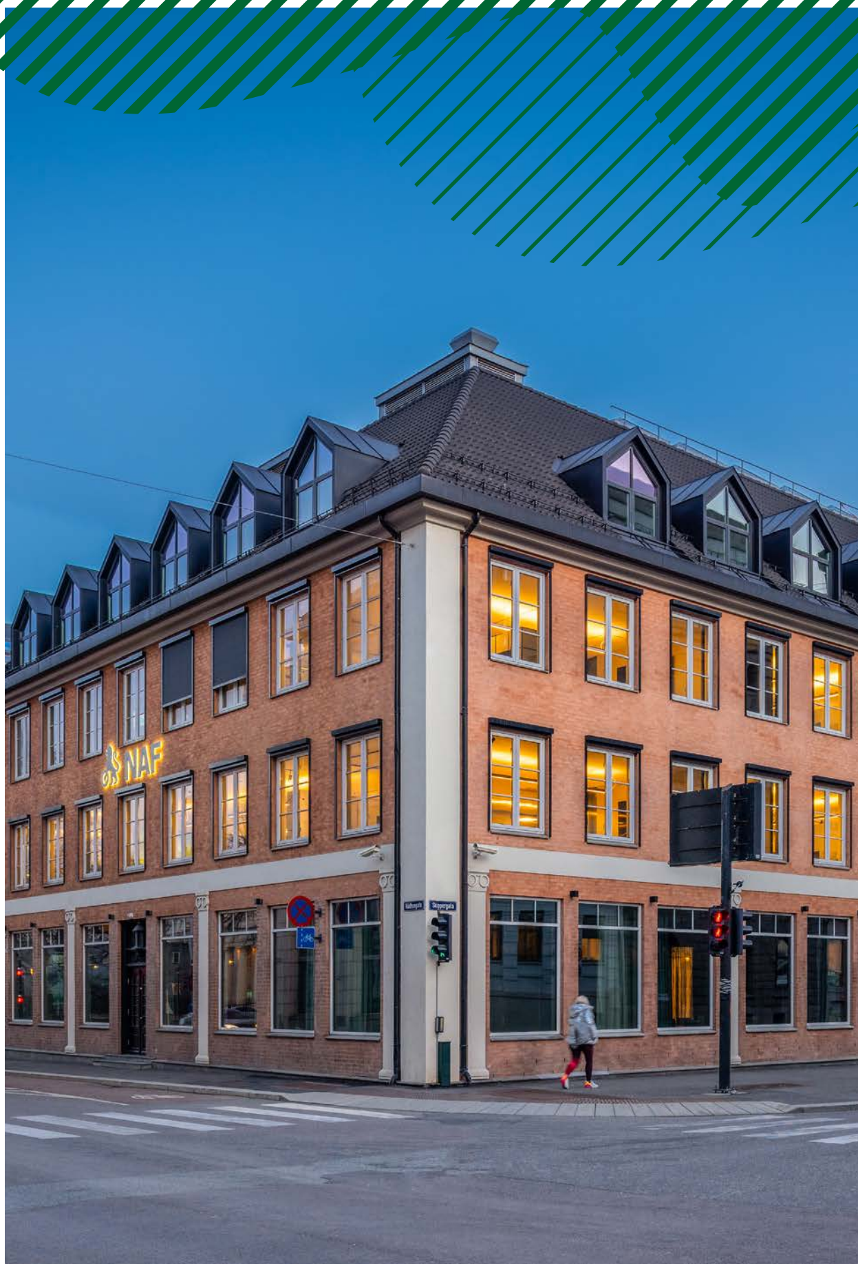
NAF sitt nye hovedkontor i Rådhusgaten i Oslo, totalrehabilitert i 2018.
