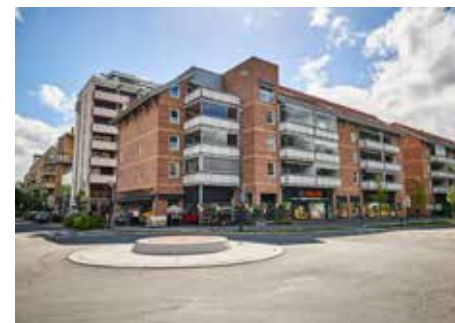
Bankveien 14, Asker 1 927 m 2 , næringsseksjon
