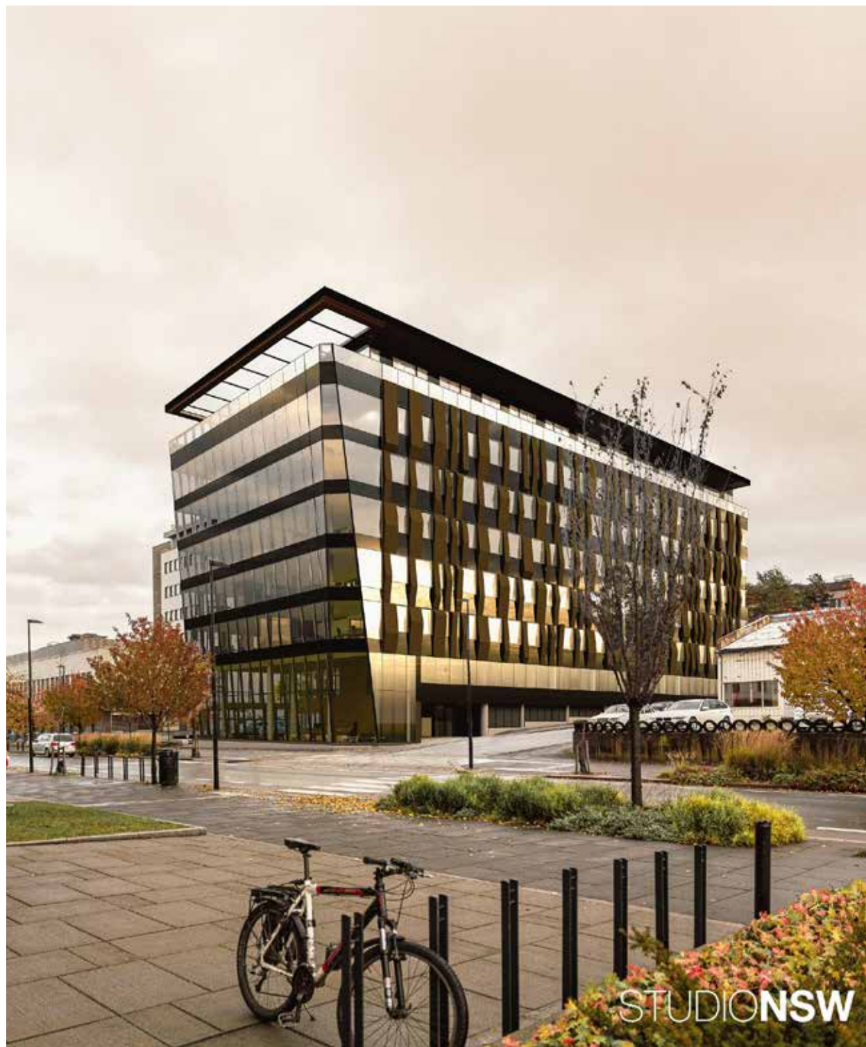
Utstillingsplassen Eiendom, hvor Hathon er medeier, bygger Eidsivabygget på Hamar som blir et flott signalbygg, 500 meter fra jernbanestasjonen i byen. Kontorbygget blir nærmere 13 000 kvadratmeter stort.
