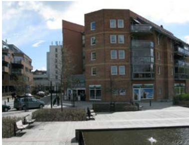
Bankveien 11, Asker • Areal: 1 642m 2 , næringsseksjon • Eierandel: 100 % • Type: Kontor/forretning
